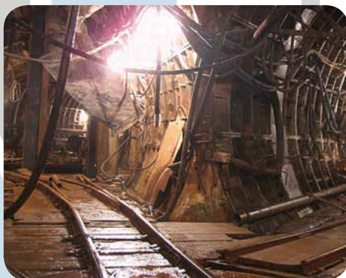
Фото с объекта
